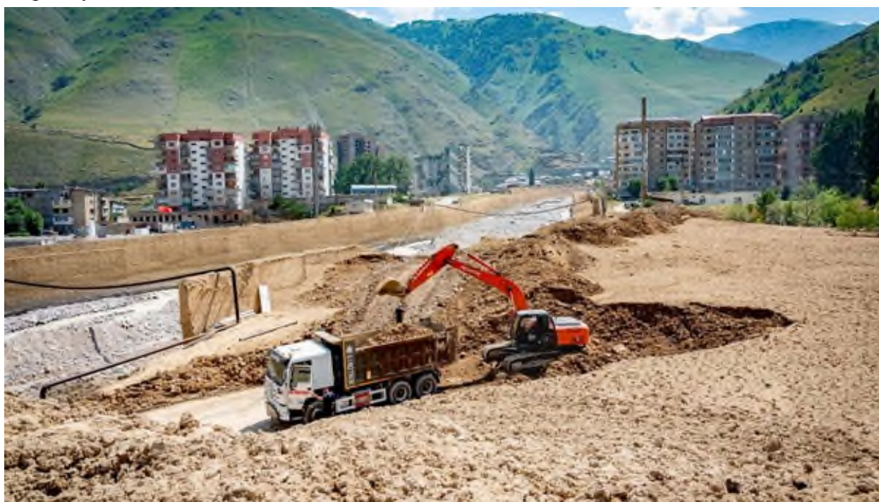
Рис. 12. Очистка города Тырныауз от селевых наносов с 21 по 31 июля 2025 г, составляющих около 50 тысяч кубометров.
